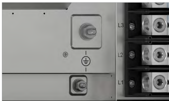
Abb. 8.13: Drehmomente an den PE-Anschlüssen
