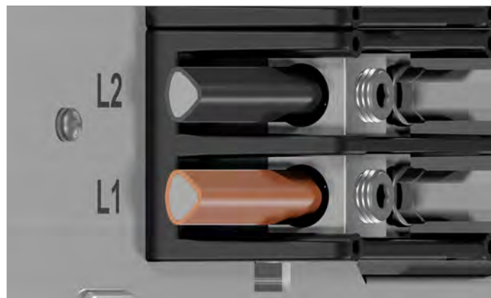
Abb. 6.19: Korrekte Lage von sektorförmigen Aluminiumkabeln (2)
